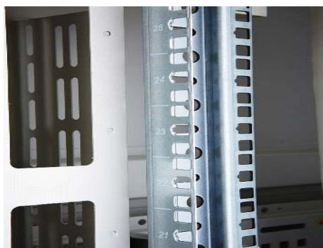
Montants 19 pouces avec incrémentation des U
